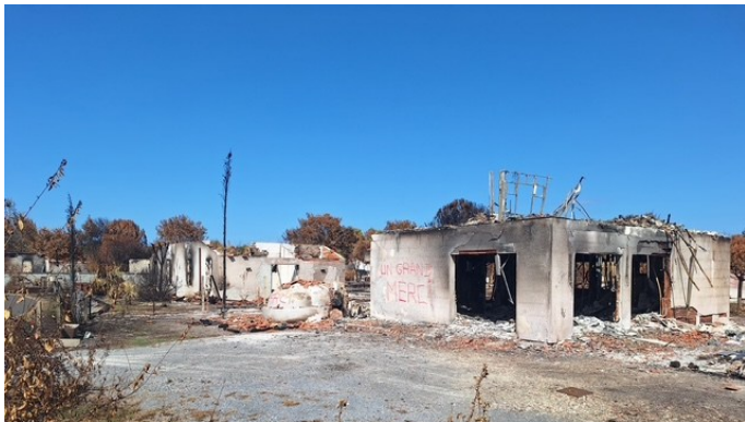
Des dizaines d'habitations et bâtiments professionnels détruits par le feu
